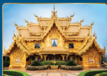
วัดร่องขุน เชียงราย อาคารหอน้ำทองคำ ❖ สีทอง AG-123 ❖
