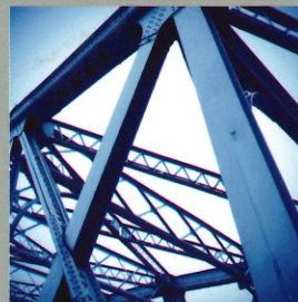
โครงสร้างเหล็ก STRUCTURAL STEEL
